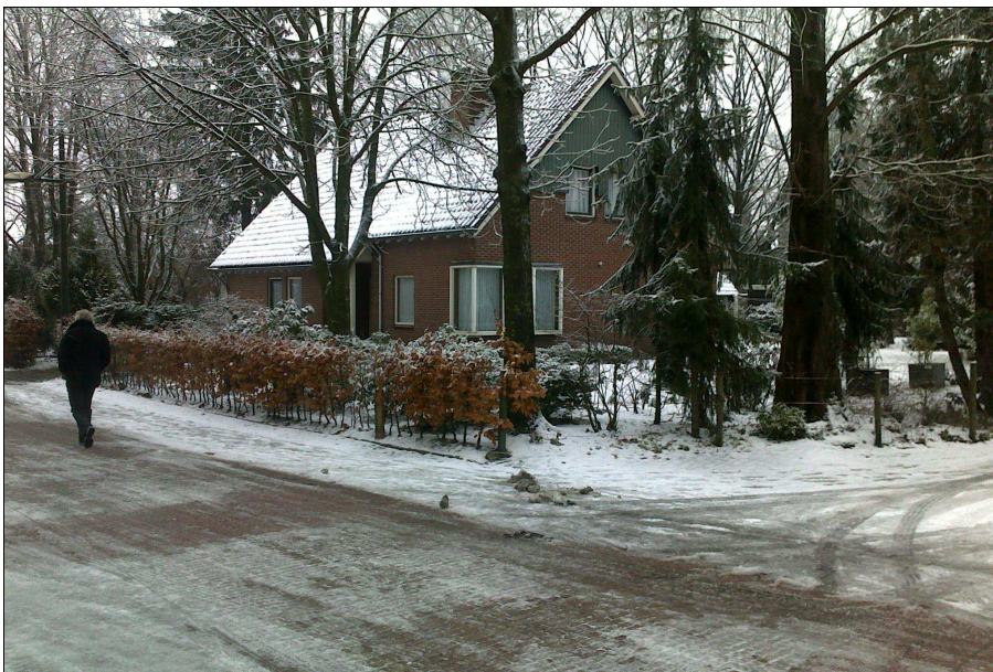
De woning aan de Kalter 2
