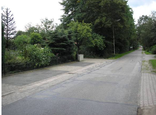
Groot trafohuisje op de kruising tussen de Kolenbranderweg en de Textielstraat
