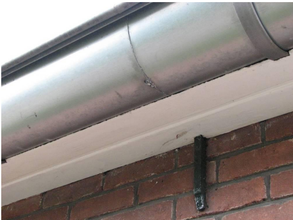
Foto 14: Ook de betimmeringen aan de zijgevel zijn naadloos.
