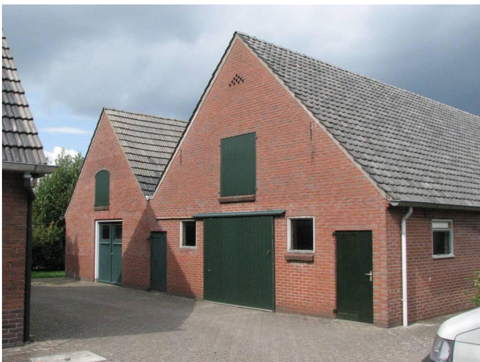
Foto 3: Overzichtsfoto van de te slopen schuren.
