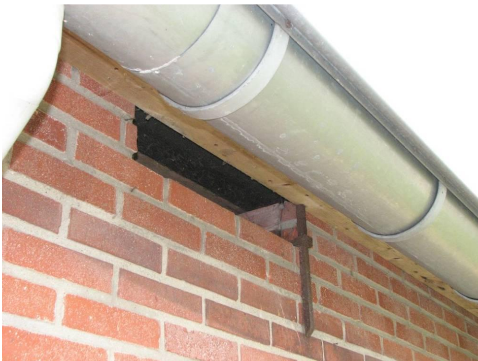
Foto 7: Opening in de zijgevel.
