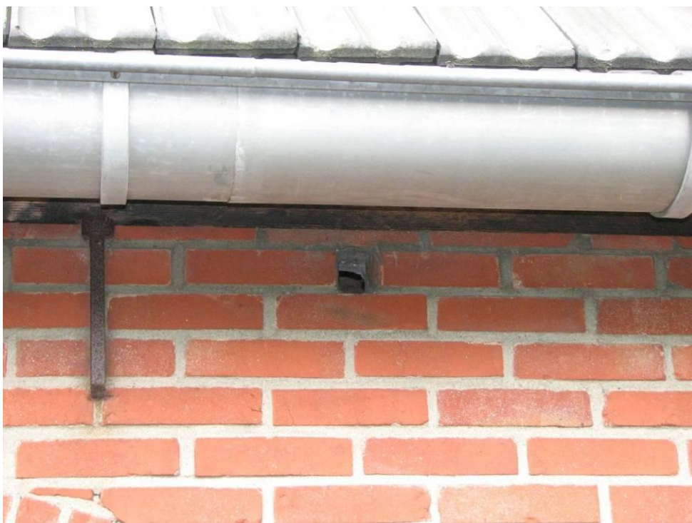
Foto 6: Opening in de zijgevel.
