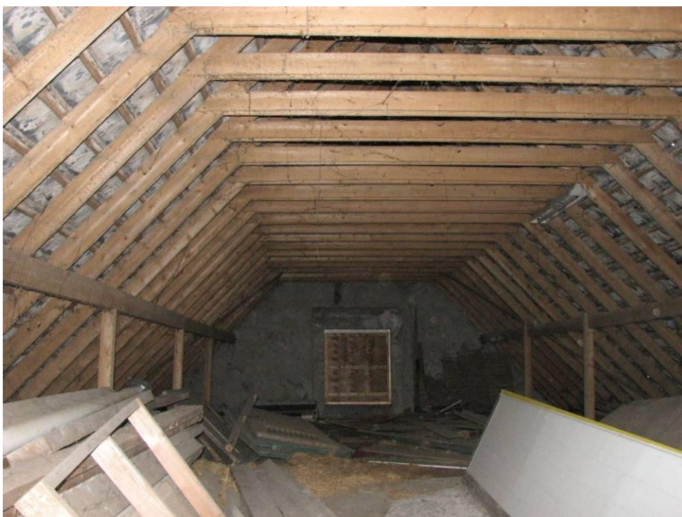
Foto 4: Zolder van de schuur.
