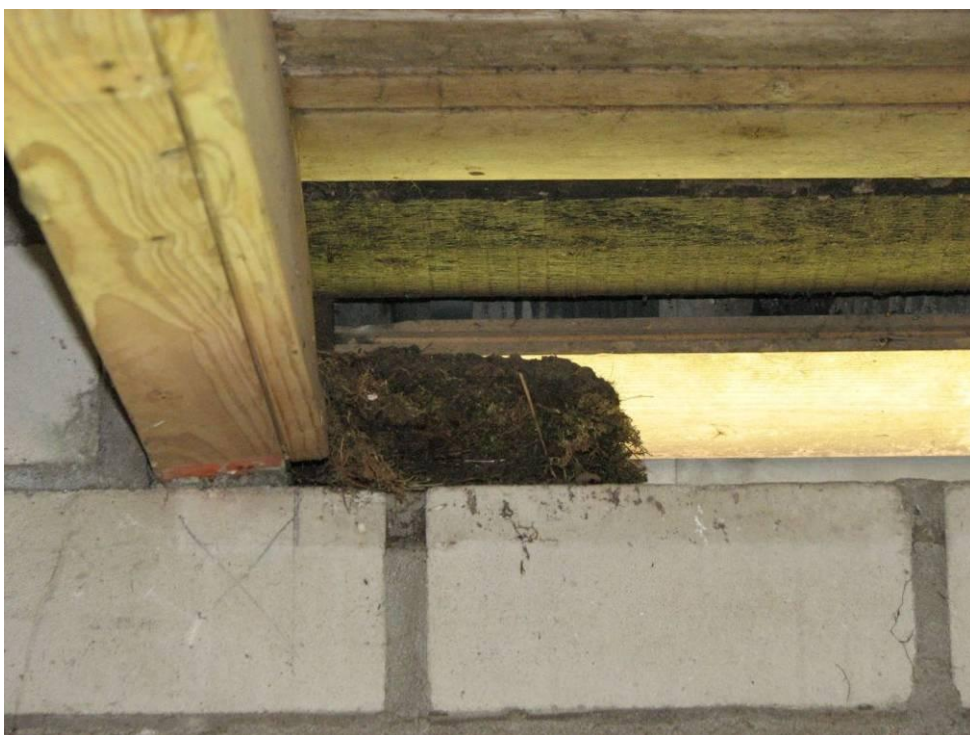
Foto 8: Een nest van een Zanglijster in één van de openingen in de zijgevel van de schuur.
