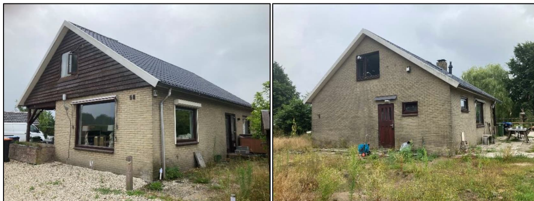
Figuur 2.3 (links): Vooraanzicht van het gebouw; Figuur 2.4 (rechts): Achteraanzicht.
