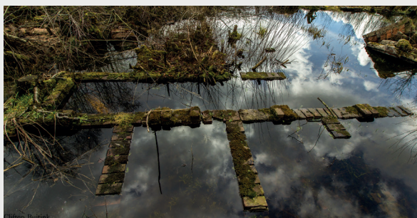
Afbeelding 7: De Gefechtsstand was een van 'gevechtsposten' langs de Nederlands – Duitse grens. De resten van funderingen en vloeren zijn nu zichtbaar.
