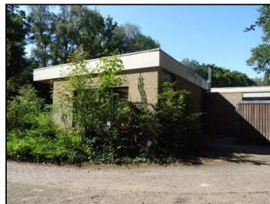
Figuur 4. Oostzijde van de school waar de nieuwe gymzaal tegenaan gebouwd moet worden.
