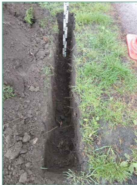
Foto Detail profielsleuf
