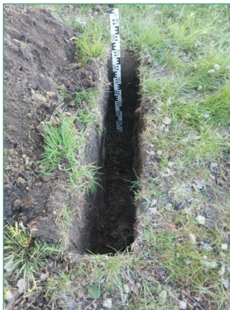
Foto Detail profielsleuf
