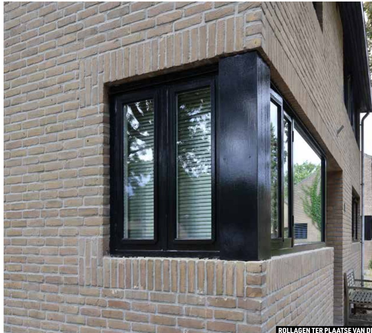
ROLLAGEN TER PLATSE VAN DE DAKBEEÏNDIGINGEN EN ROND KOZIJNEN
