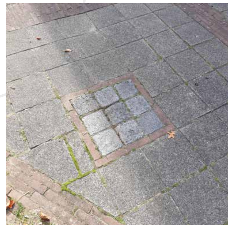
De trottoirs zijn uitgevoerd in sierbestrating.
