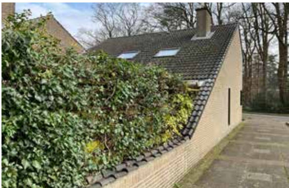
Type 1 | Doorlopende tuinmuren.
