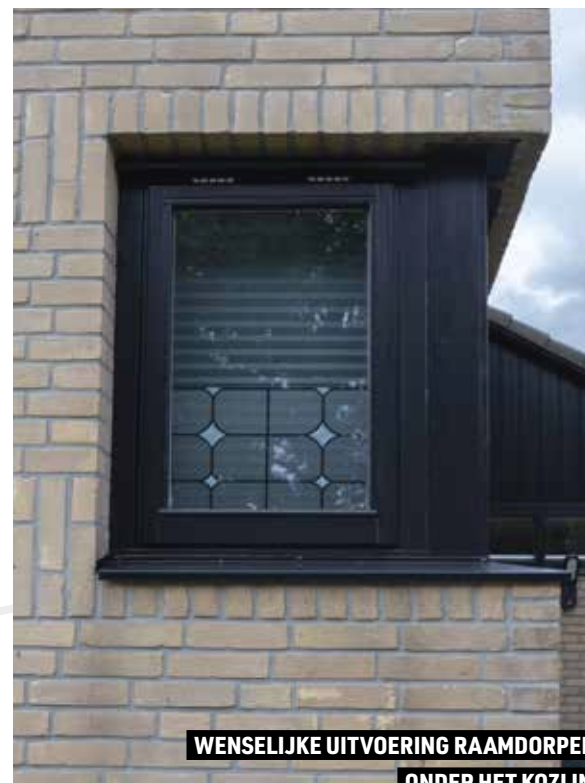
WENSELIJKE UITVOERING RAAMDORPEL ONDER HET KOZIJN
