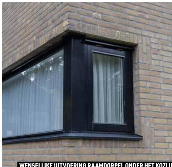
WENSELIJKE UITVOERING RAAMDORPEL ONDER HET KOZIJN
