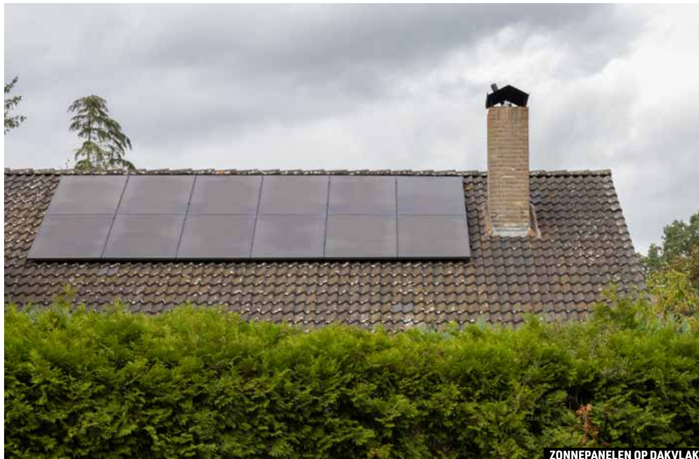
ZONNEPANELEN OP DAKVLAK
