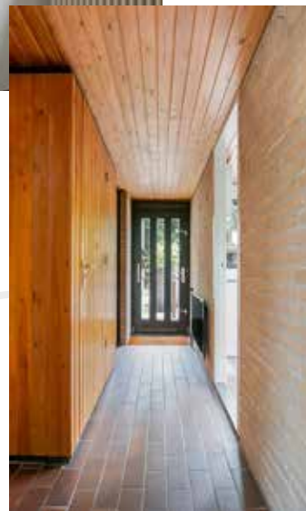
Gebakken tegels en houten schroten aan het plafond
