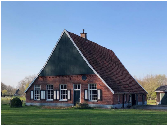
1 Typologie: Boerderij Functie: Wonen Bouwjaar: ca. 1888 (verbouw 2023 - 2024 ) Wens: revitaliseren in uitvoering
