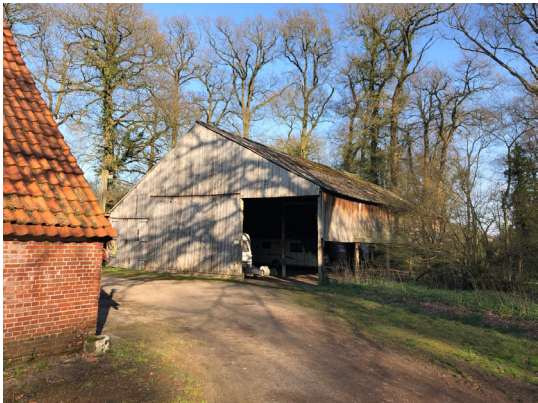
3 Typologie: Kapschuur Functie: Opslag Bouwjaar: ca. 1888 Wens: slopen en nieuwbouw
