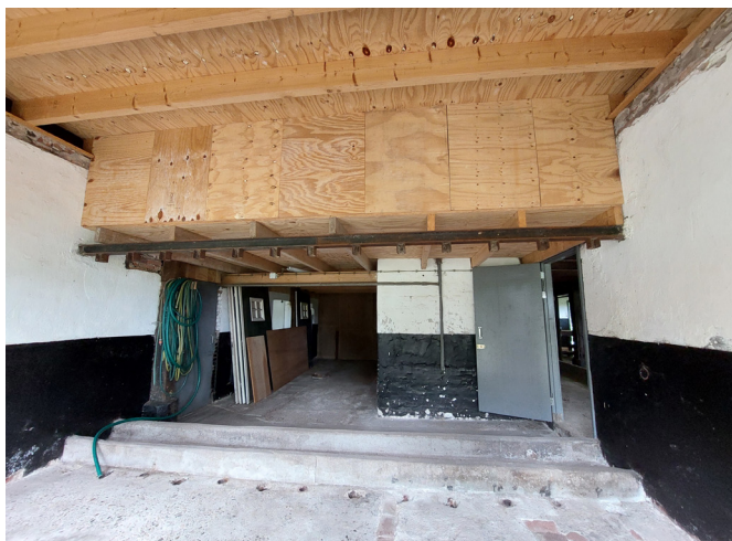
Afb. 69 Zicht richting tas vanuit voormalige jongveestal met nieuwe balklaag en vloerdelen.
