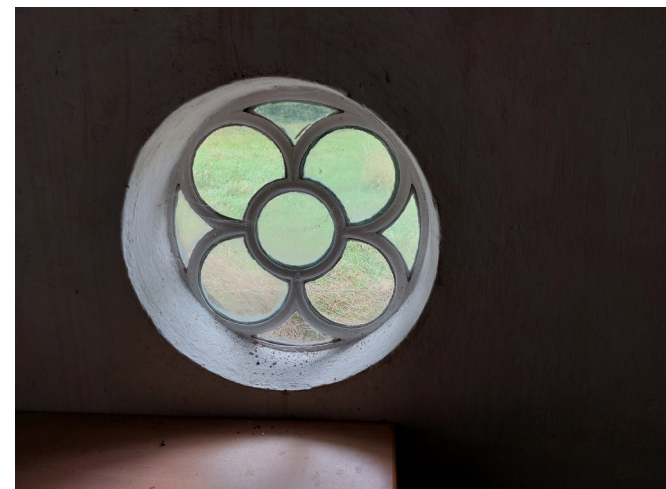
Afb. 76 Oorspronkelijke ronde vensters van voormalige varkensstal.
