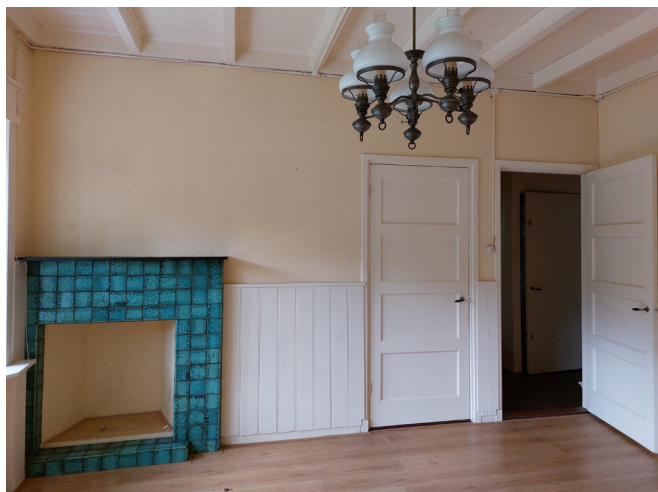
Afb. 63 Woonkamer met schouw, lambrisering en paneeldeuren.
