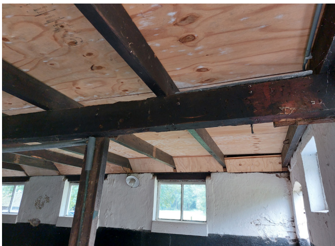
Afb. 68 Onderslagbalk en vernieuwde vloerdelen en afwerking koeienstal.
