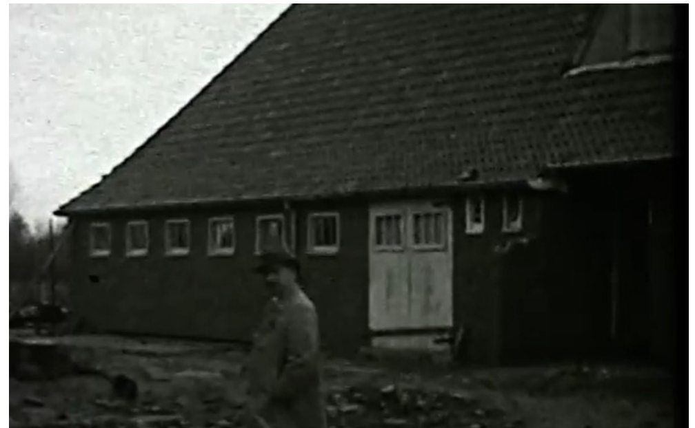
Afb. 24 Boerderij tijdens de bouw in 1928 met de oorspronkelijke stalvensters en deeldeuren voor het uitrijden van de wagen. Dhr. Blom loopt voorlangs. (Youtube: Filmstill van opname D.J. Blom, 1928).
