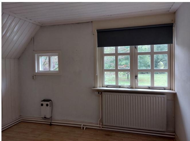
Afb. 66 Kamer voor verdieping met later aangebracht plafond.
