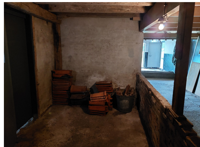
Afb. 70 Recent ingetimmerde ruimte in de tas.
