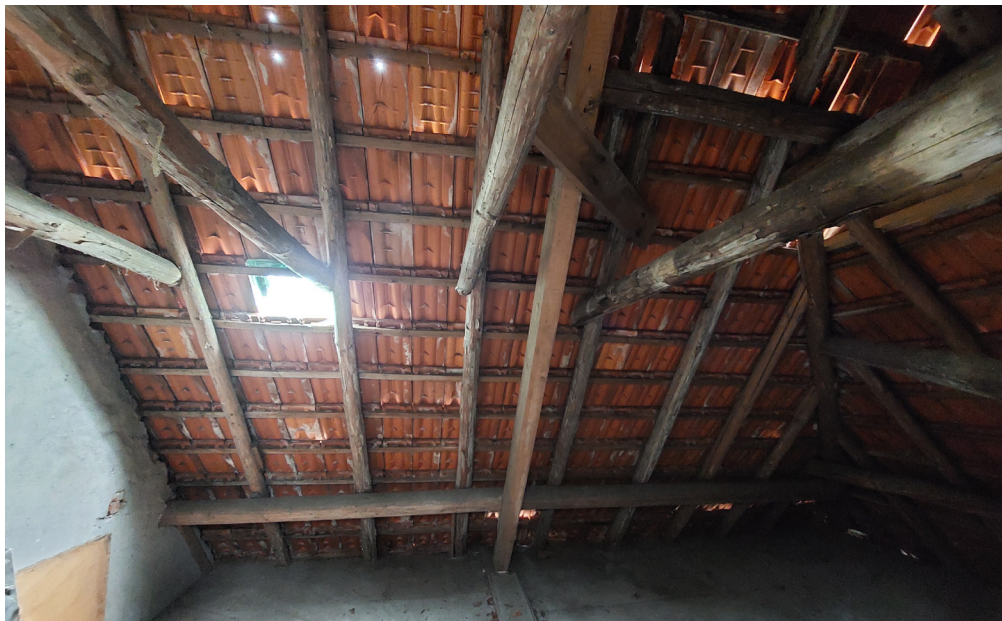
Afb. 42 Zolder en kapconstructie woonhuis.
