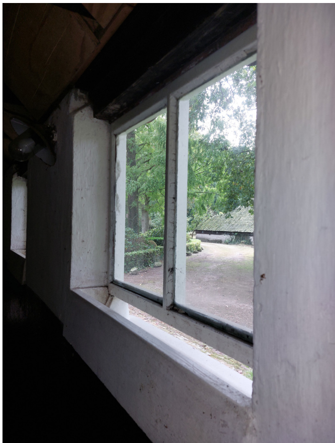
Afb. 26 Ventilerende stalvensters uit de jaren '50.
