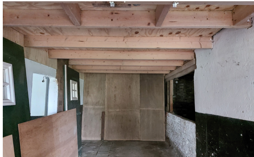
Afb. 46 Doorbraken tussen tas en varkensstal en nieuwe balklaag.
