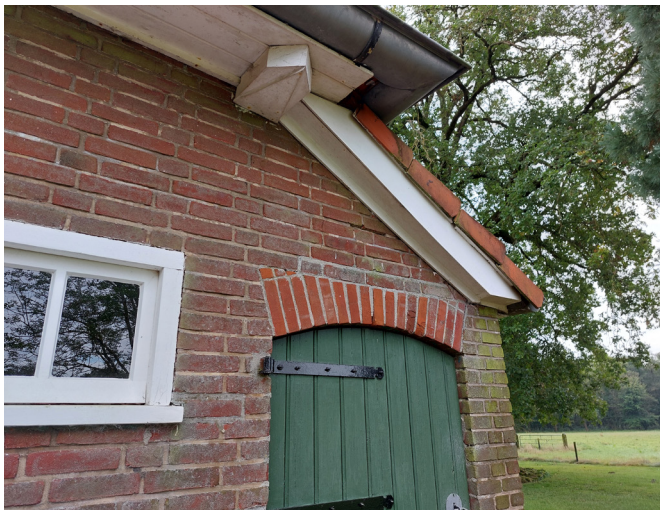
Afb. 33 Vervangen getoogde deuren, met later aangebrachte getoogde strekken.
