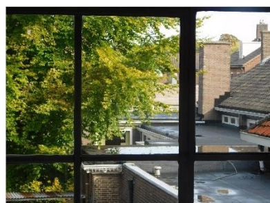
Figuur 2.8 dakencomplex noordzijde.
