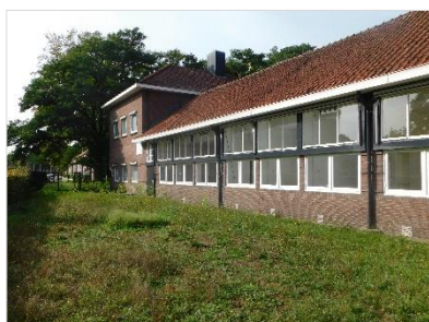
Figuur 2.7 Overzichtsfoto schoolgebouw oostzijde.
