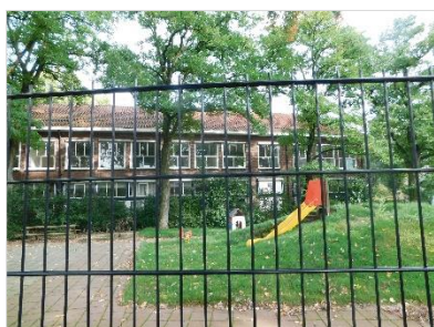
Figuur 2.6 Overzichtsfoto schoolgebouw zuidzijde.
