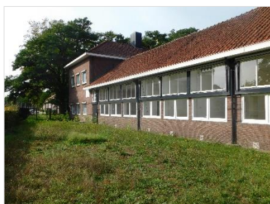
Figuur 2.7 Overzichtsfoto schoolgebouw oostzijde.
