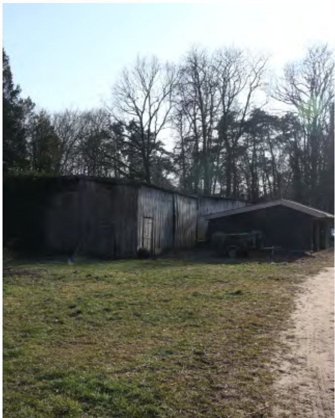
Afbeelding 5. Te slopen opstallen.
