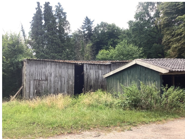
Schuur met asbestdak links op de foto
