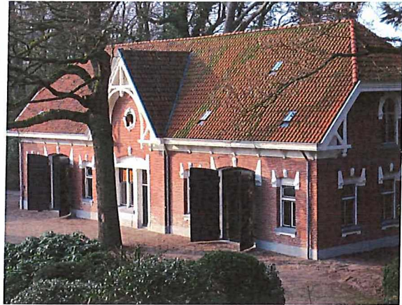
Koetshuis na restauratie
