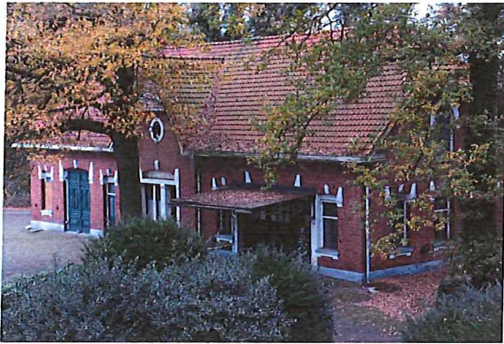
Koetshuis voor restauratie
