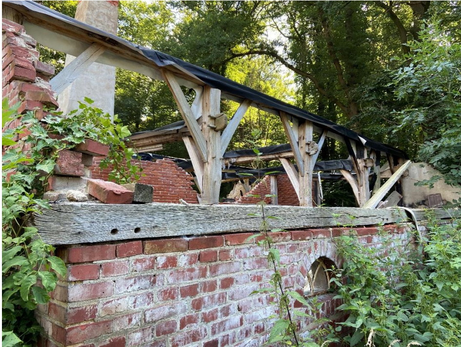
Afb. De gaten waar de vakwerkstaanders onder de muurplaat hebben gestaan zijn duidelijk te zien.
