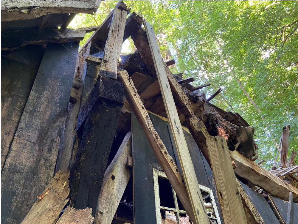
Afb. De hangende regel van het voormalige vakwerk, de gaten nog duidelijk zichtbaar. Buitenste gebint voorzien van elleboogje waar de topgevel op heeft gestaan.
