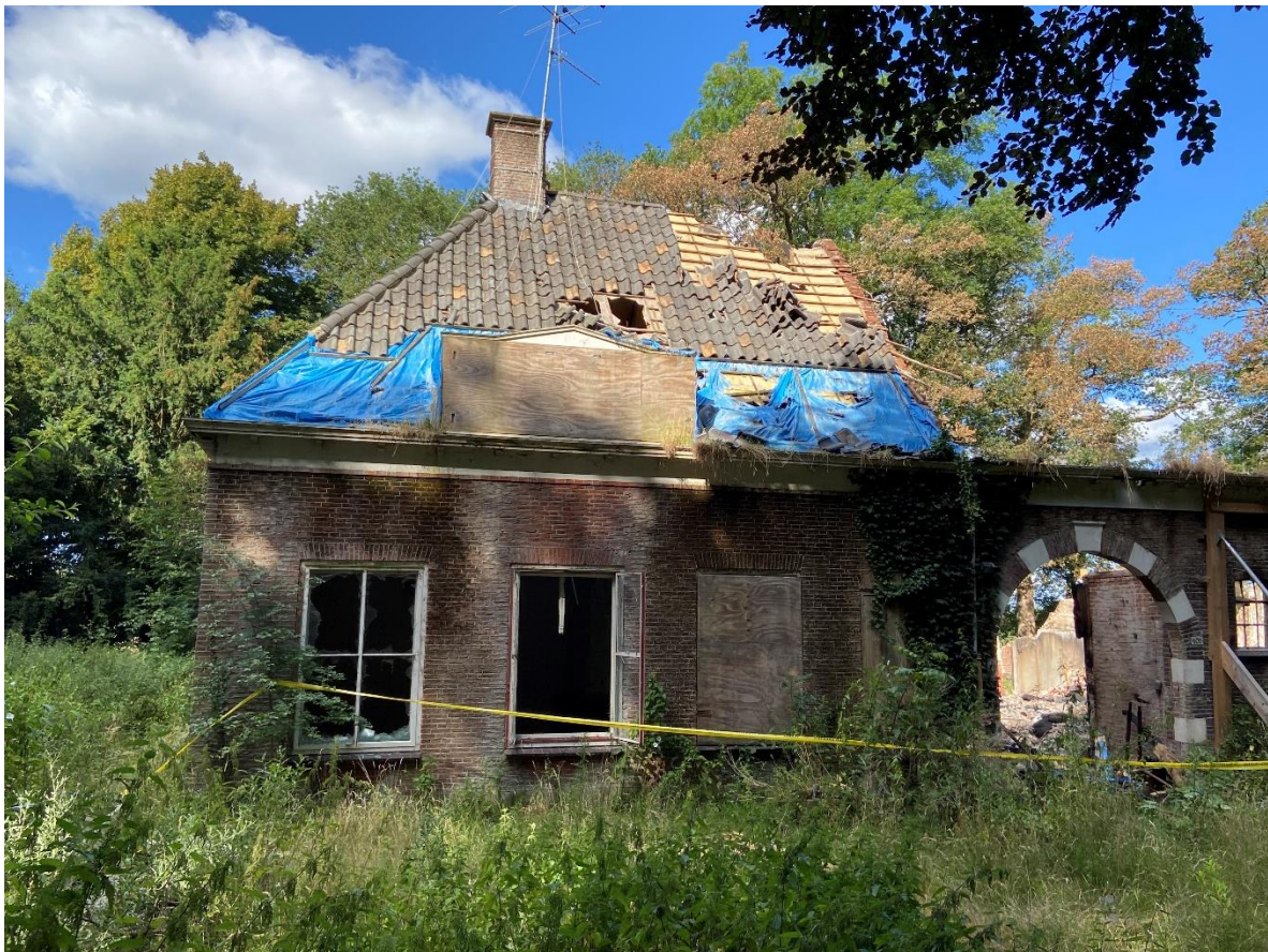
Afb. Een klein stuk dakvlak van het voorhuis heeft standgehouden. De staat van de constructie is niet te inspecteren.
