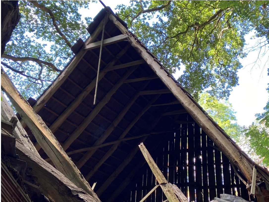
Afb. Deels ingestorte kap, maar geheel opgebouwd uit eikenhout.
