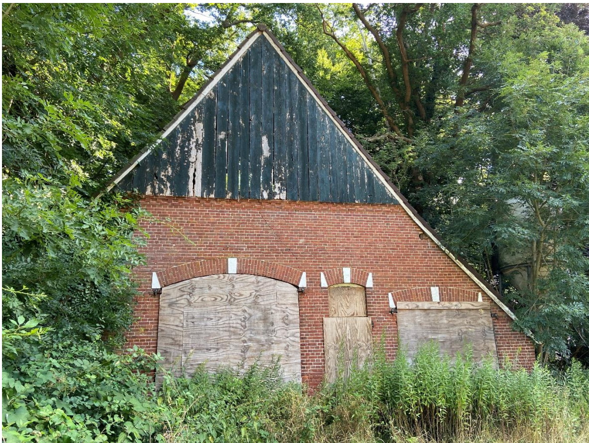
Afb. De voorgevel van de niet beschermde schuur.
