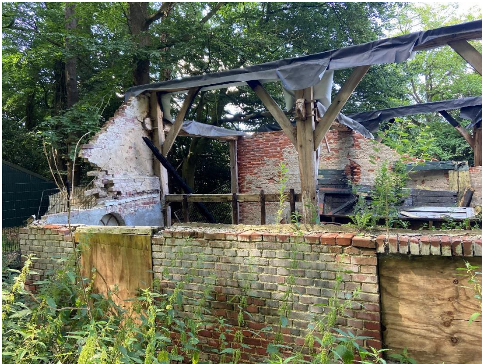
Afb. Achterhuis van de boerderij met steekrij en reppels nog aanwezig.
