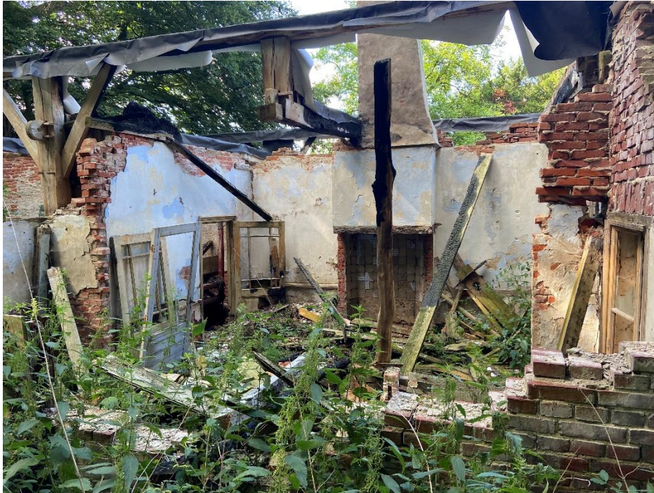
Afb. De indeling van de boerderij is nog redelijk intact gebleven.
