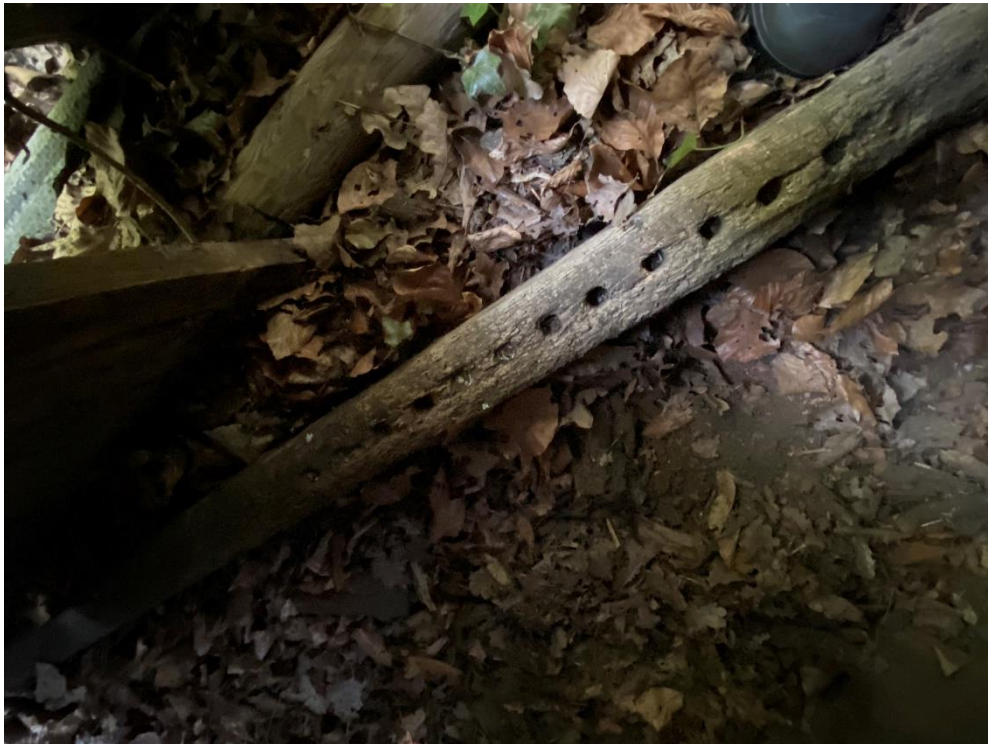
Afb. Nog een losliggende regel met de sporen van voormalig vakwerk.
