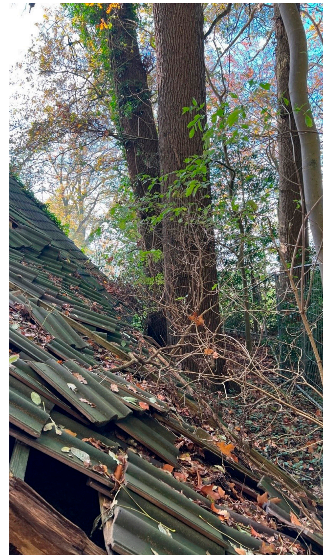
Eiken direct langs gevel van bestaand gebouw E
