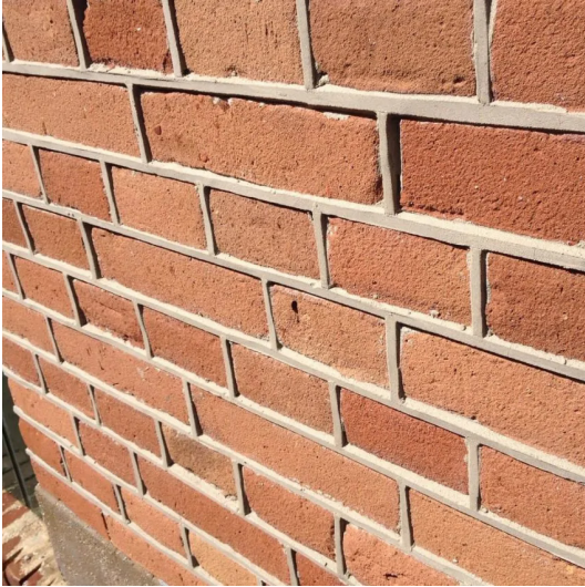
Voegwerk door middel van knipvoeg.
