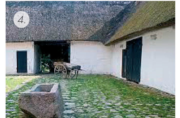
Verharding van bestaande veldkeien
