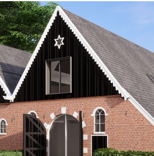
Houten beschieting aan de gevel: eiken planken, gezwart met ecoleum
