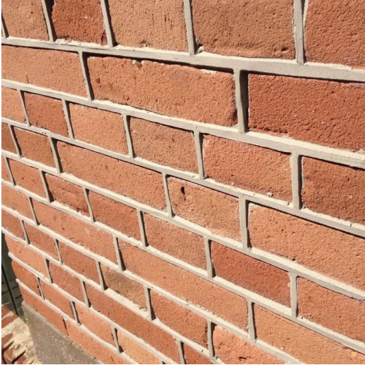
Voegwerk door middel van knipvoeg.
