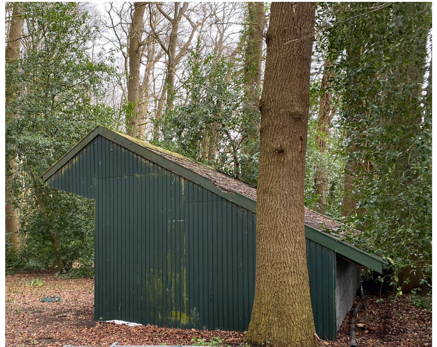
Bestaand bijgebouw nabij woongebouw B wordt opgeknapt en kan worden gebruikt als parkeergelegenheid
