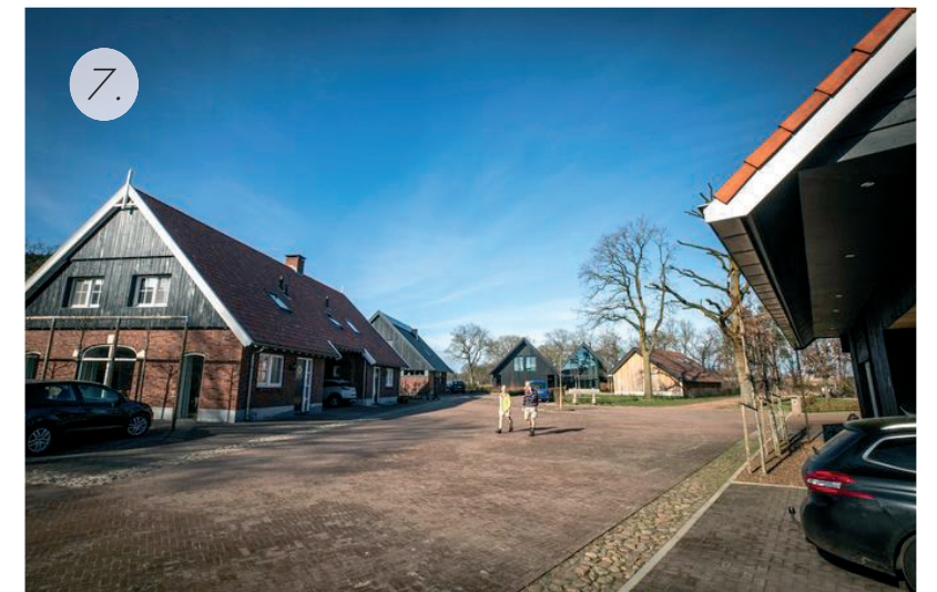
Oprijlaan en parkeerplaatsen van gebakken klinkers
