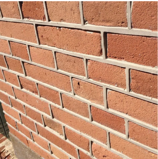
Voegwerk door middel van knipvoeg.
