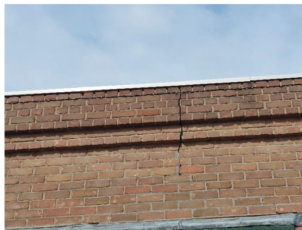
Figuur 18. Loodsen, momenteel in bruikleen. Hier zijn diverse scheuren aangetroffen die toegang bieden tot de spouwmuren.
