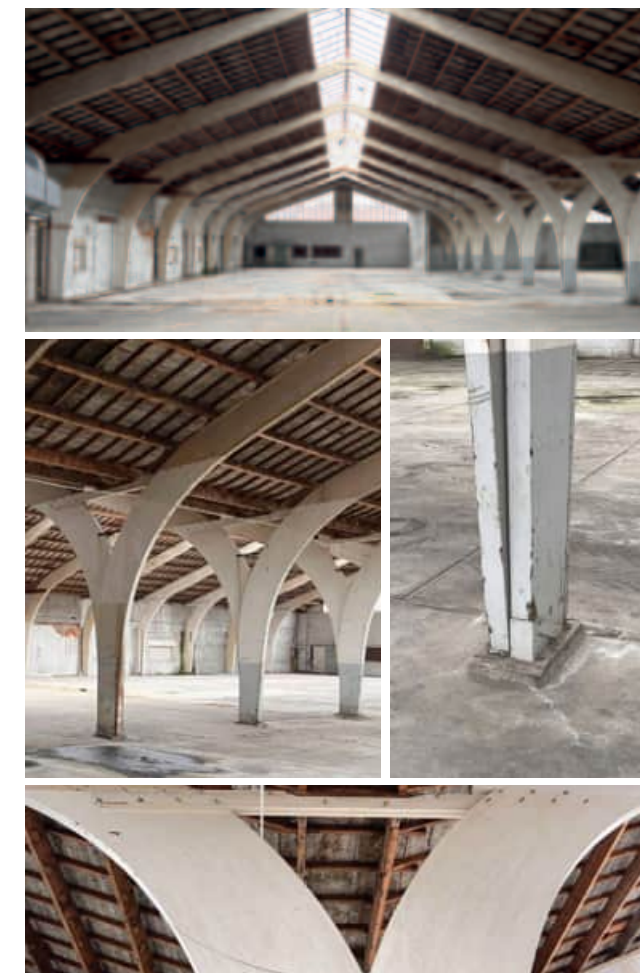
De spanten in de huidige staat
