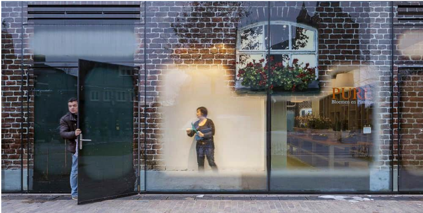
De nieuwe toevoeging accentueert de oorspronkelijke architectuur (MVRDV Glass Farm, Schijndel).
