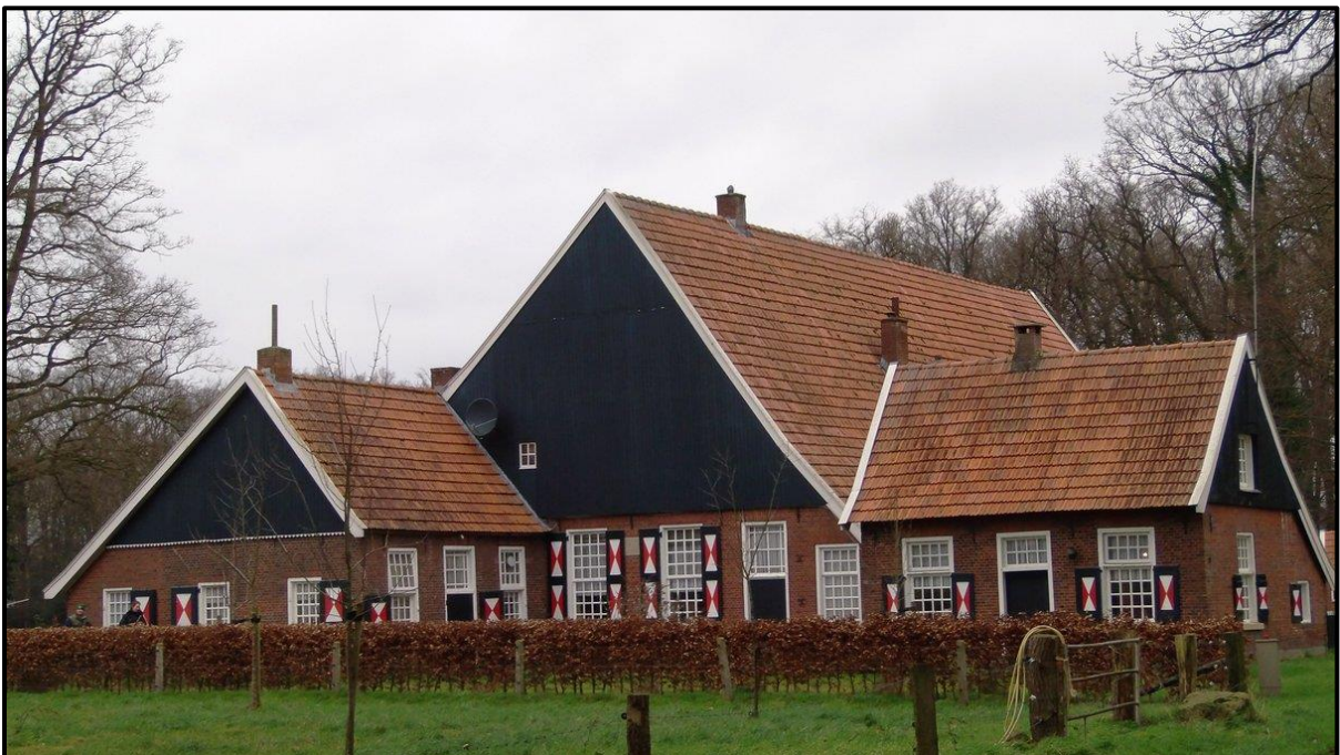
Afb. 3.9 Zicht op het boerderijcomplex Groot Brunink dat gelegen is op het gelijknamige landgoed dat eigendom is van Landschap Overijssel. Vanuit de boerderij wordt een biologisch melkveebedrijf geëxploiteerd. De nabij gelegen wijk Het Brunink ontleent zijn naam aan die van het landgoed.
