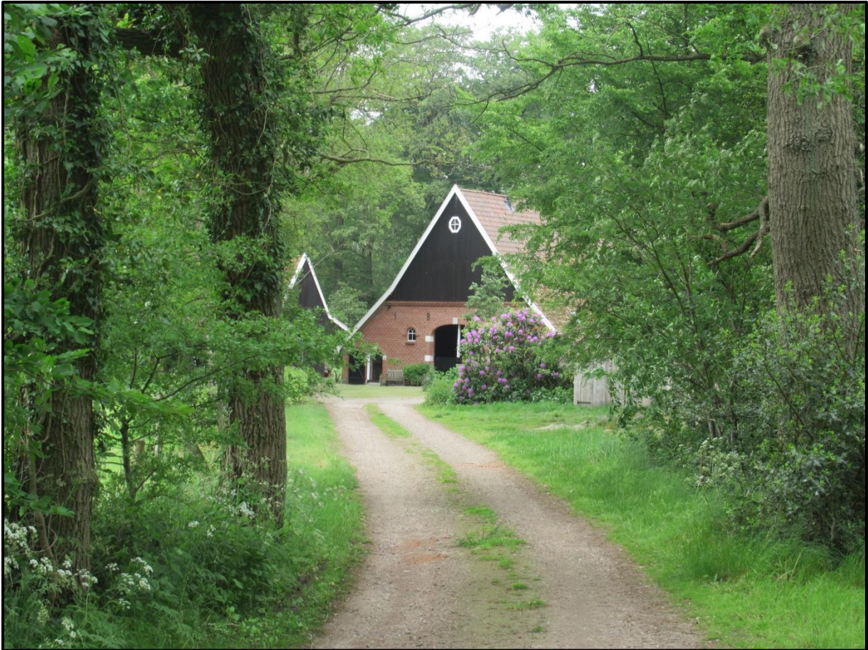
Afb. 2.9 Landgoed De Kuper, gelegen aan de Lossersestraat, dankt haar naam aan het erve De Kuper waarvan de eerste vermelding dateert van 1554. In 1970 waren de boerderij en bijgebouwen onbewoond en verlaten. Door verval en vandalisme werden de opstallen, die toen reeds een monumentale status hadden verkregen, aangetast. In 1986 kwam De Kuper in eigendom bij dhr. J.J. Zwaferink uit Losser. Hij stelde alles in het werk om het erf weer bewoonbaar te maken en liet de gronden en opstallen rangschikken onder de NSW als landgoed. Er werd een wandelroute aangelegd en werkzaamheden verricht om de natuurwaarden op het landgoed te verhogen. De Kuper is, samen met het ertegenover gelegen landgoed De Elsbeek dat vroeger onderdeel was van De Kuper, één van de parels binnen het type boerderijlandgoederen. Het landgoed kent een oppervlak van circa 21 hectare met onder meer bossen, poelen, weilanden en akkers.
