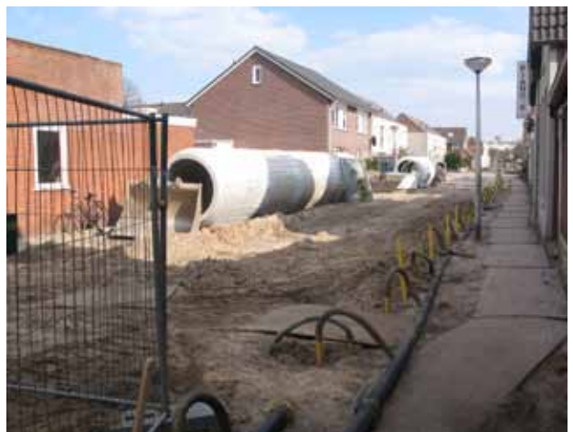
Vervanging riolering
