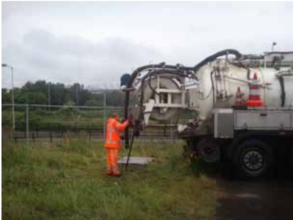
Reinigen en inspecteren riolering
