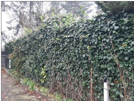
Foto 5 Klimop oostelijke zijde perceel
