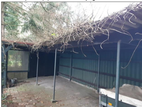
Foto 8 Opstal op perceel (oostelijk gericht)
