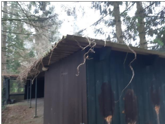
Foto 9 Opstal op perceel (oostelijk gericht)
