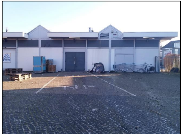
Foto 6. Achterzijde (westzijde) supermarkt.
