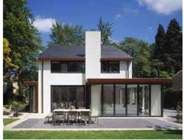
Helder en strak bouwvolume
