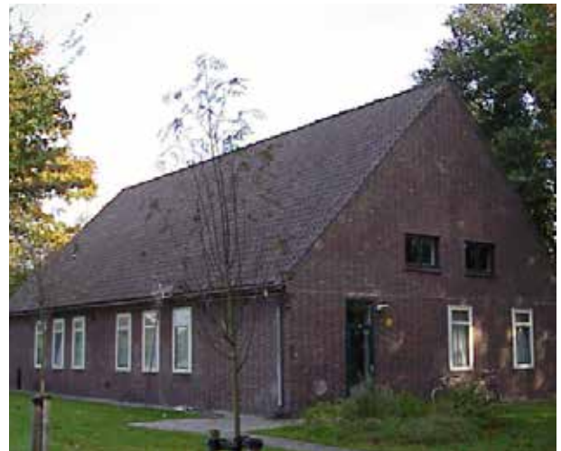
aangetast door niet passende kozijnen
