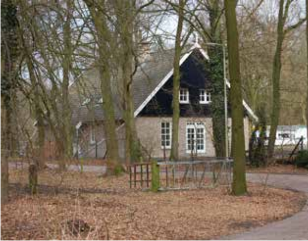
Verbouwde standaardtype boerenschuur met Twentse kenmerken, Sprakelweg
