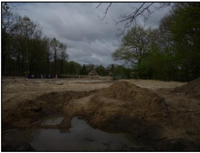
Figuur 15. Op een deel van het terrein hebben graafwerkzaamheden plaatsgevonden.
