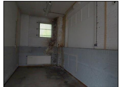
Figuur 8. Binnenzijde van het leegstaande pand.
