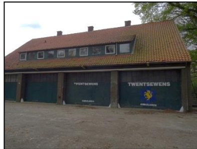
Figuur 7. Zadeldak met dakpannen en bestraat terrein.
