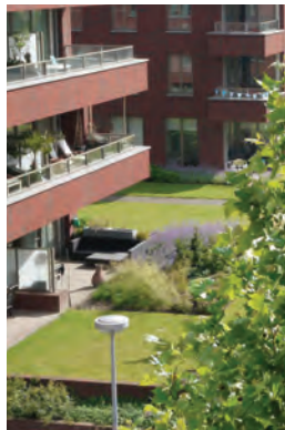
Buitenruimte op de begane grond.
