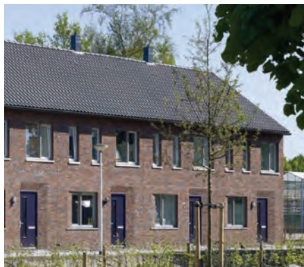
Rijwoningen met langskap en antraciete dakpannen
