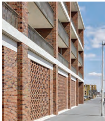
Horizontale geleiding en detaillering in het metselwerk.
