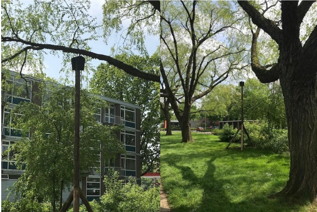
Reeds aangebrachte vleermuiskasten op palen. Deze zijn in april 2021 geplaatst.
