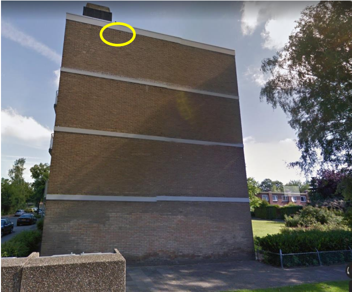
Aanzicht op de verblijfplaats van een gewone dwergvleermuis in de zijgevel van een gebouw. De vleermuis betreedt de spouwmuur via een open stootvoeg in de 4 e verdieping. De locatie van de invliegopening wordt met de gele ovaal aangeduid.
