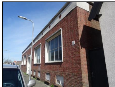
Figuur 4. Westgevel van de bebouwing op de onderzoekslocatie.
