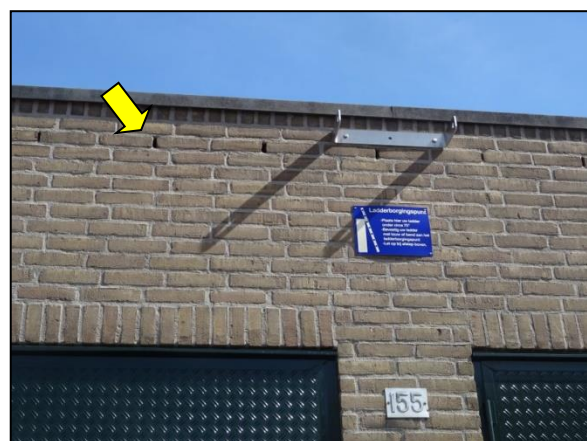
Figuur 11. Open stootvoegen die toegang geven tot de spouwmuur in het elektriciteitsgebouw aan de Getfertweg.
