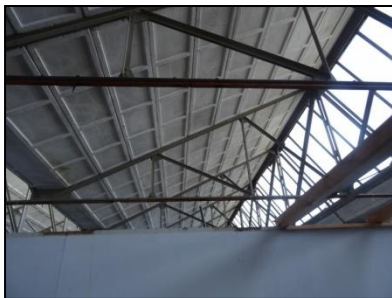
Figuur 3. Binnenzijde van het voormalige fabrieksgebouw.
