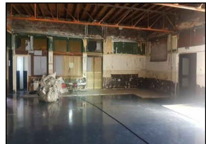
Figuur 5. Voormalige dansvloer.
