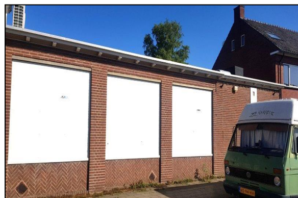
Figuur 10. Plat dak en overstek op de onderzoekslocatie.
