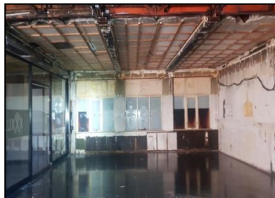
Figuur 4. Binnenzijde van de onderzoekslocatie.
