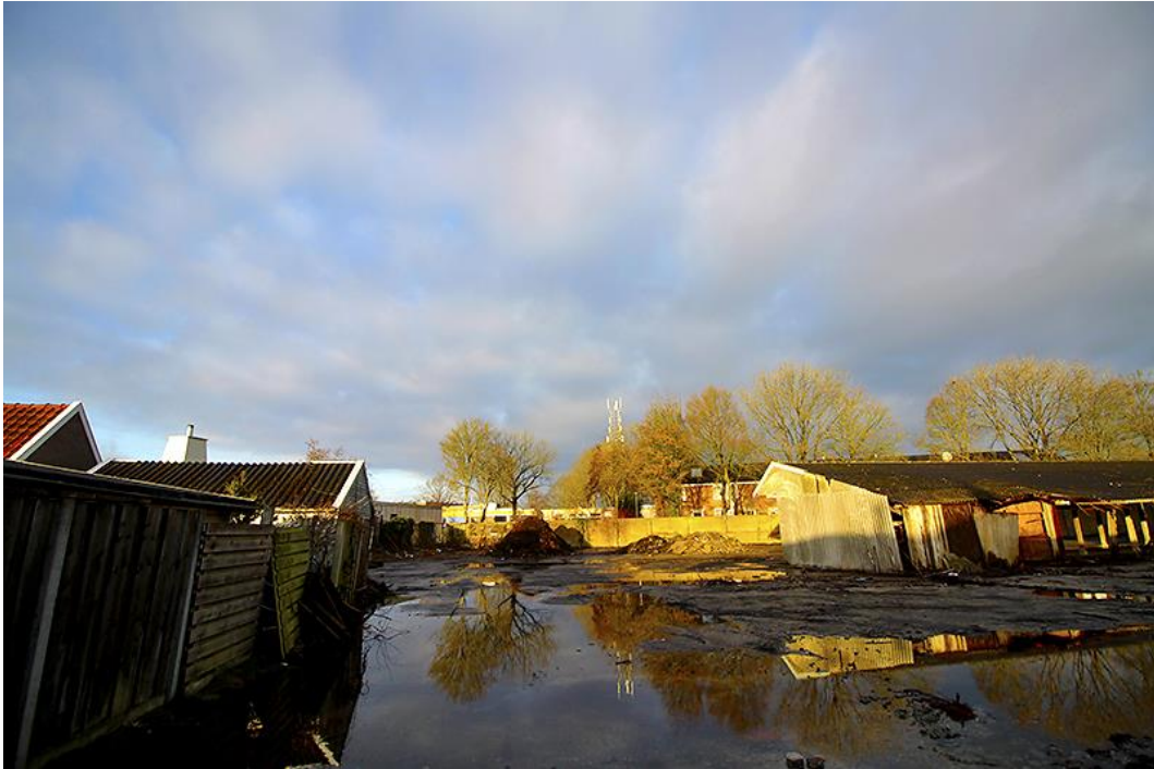
Planlocatie te slopen opstallen
