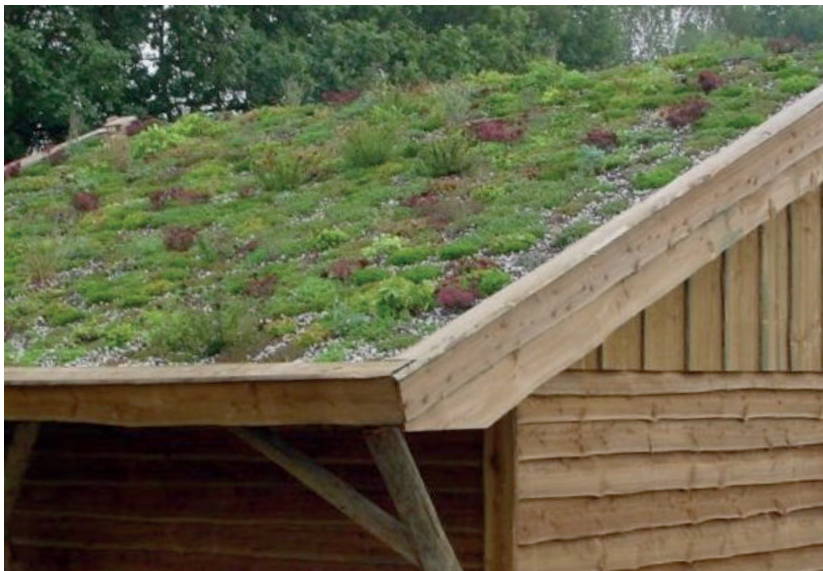
Referentie - Zijde spoorlijn: laag aangekapt, beeld vegetatiedak domineert
