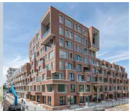
Verschillende hoekoplossingen en verspringingen in de gevel
