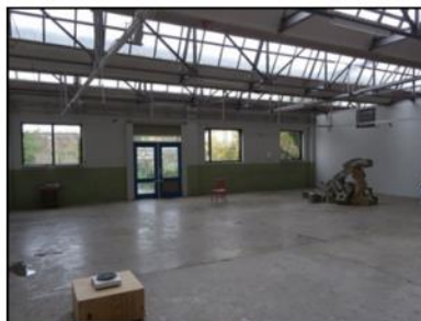
Figuur 4b. Binnenzijde van te renoveren deel van gebouw 1.
