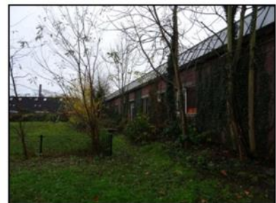
Figuur 4c. Zicht op begroeiing en de zijgevel van gebouw 1.
