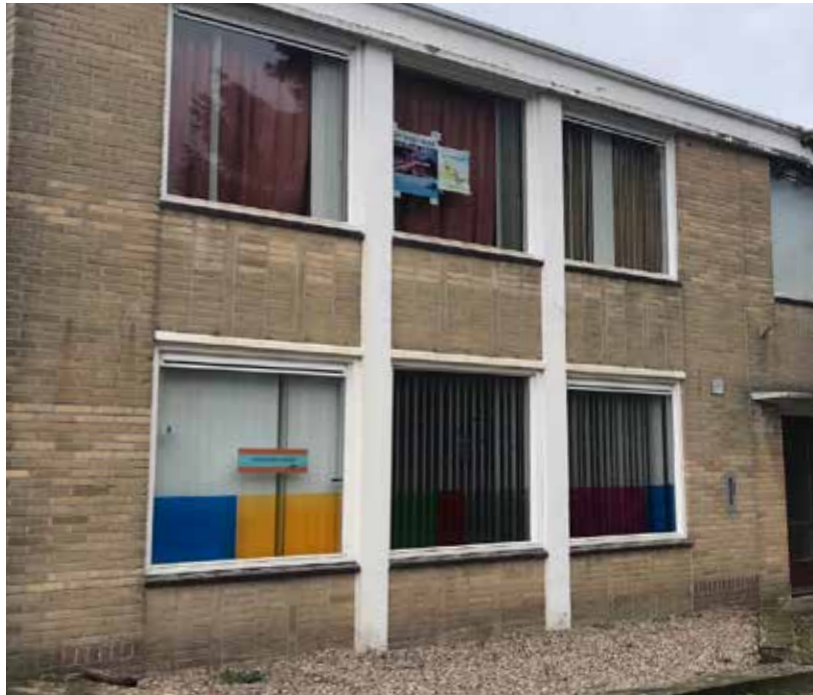
De huidige bedrijfsbebouwing. Verbijzonderd, licht metselwerk met beton
