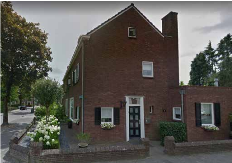
Erkers en lijstwerk geven de woningen iets extras
