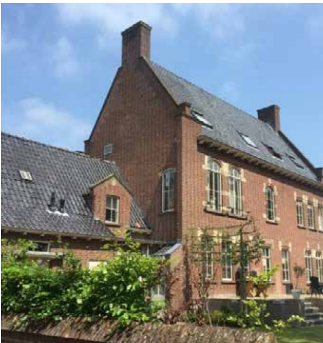
Steile kappen met keramische pannen en ondergeschikte dakkapellen
