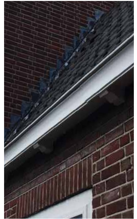
Aandacht voor mooie overstekken en gootdetails
