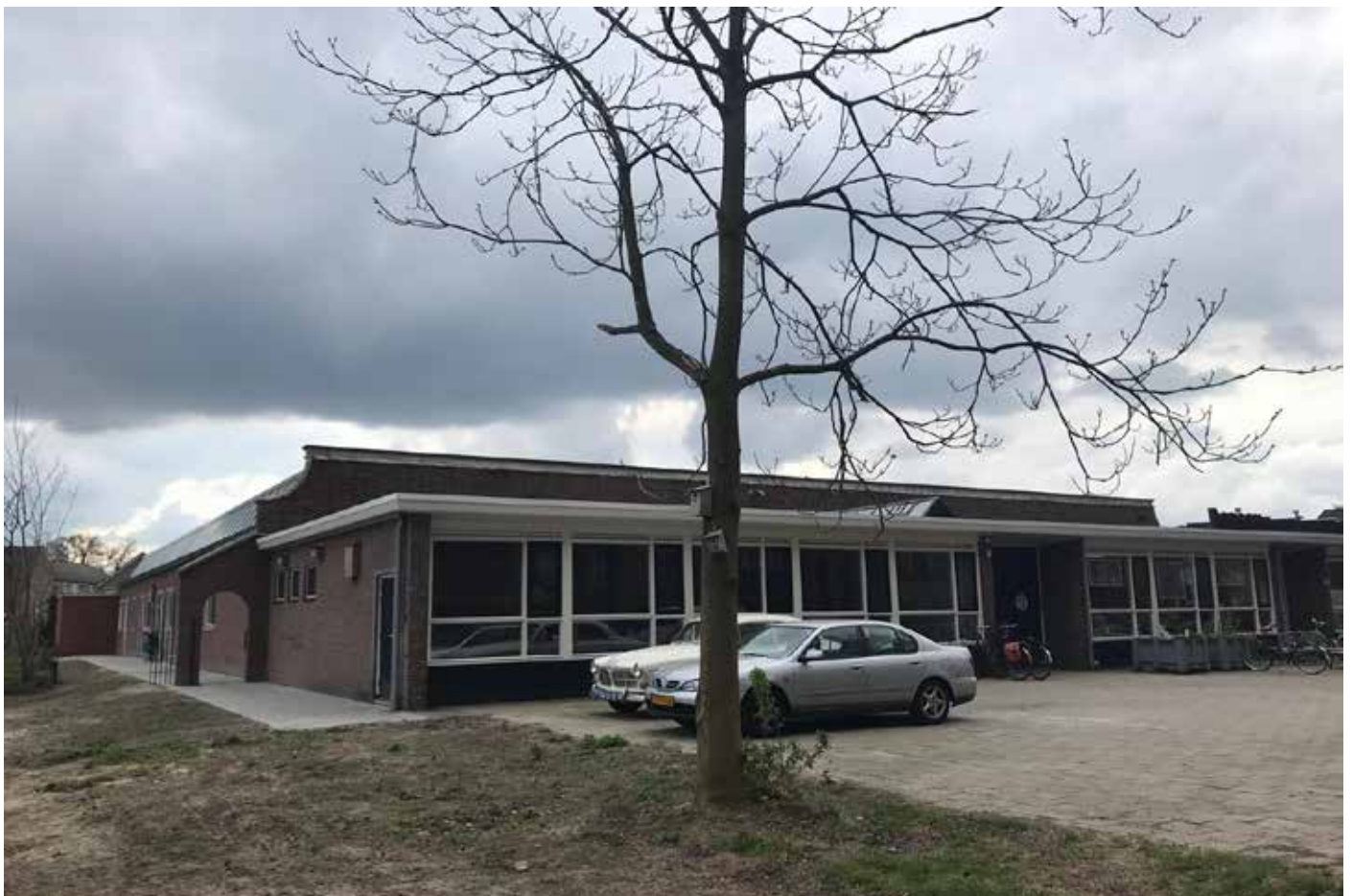
De oude oorspronkelijke voorgevel van de Robsongfabriek is nog intact en is opgenomen in de latere uitbreiding die ervoor geplaatst is. Het karakteristieke poortje maakte hier onderdeel van uit.
