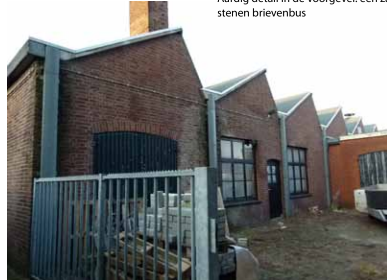
Plek waar voorheen het schaftlokaal was. Aan de rechterzijde achteraan is de aanbouw van 1964 te zien.
