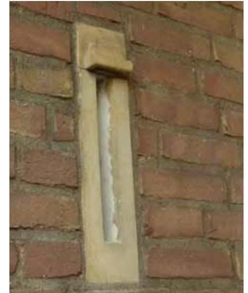
Aardig detail in de voorgevel: een zandstenen brievensbus
