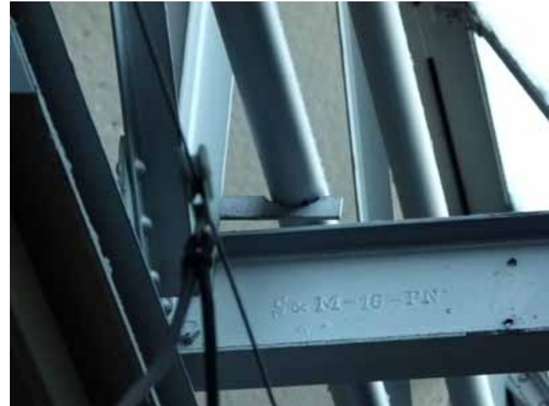
Kenmerk van een staalfabriek. Het staal voor de constructie kwam van meerdere leveranciers
