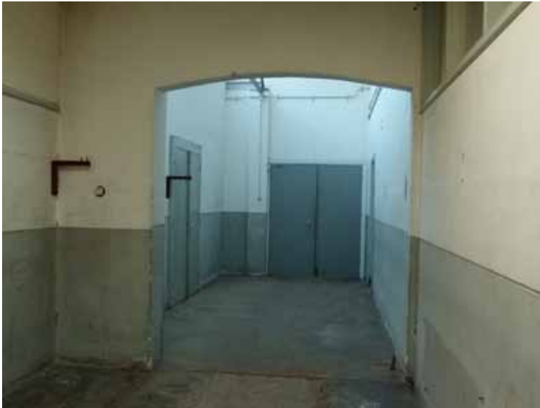
De expeditietoegang, aan de voorzijde is de oude voorgevel nog zichtbaar
