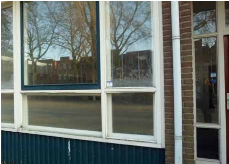
Vensterpui met dubbele ramen
