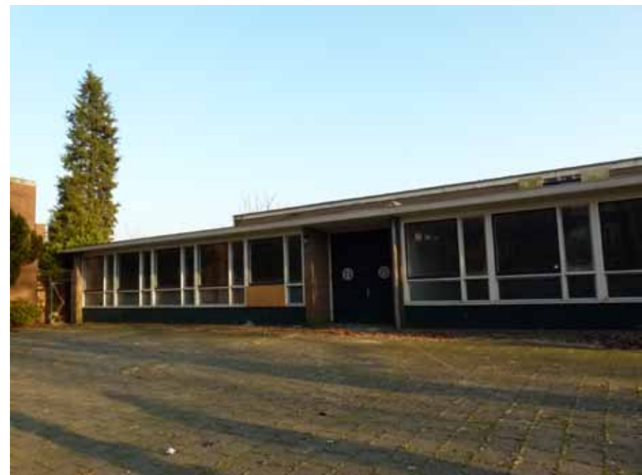
Voorgevel van het bouwdeel uit 1955
