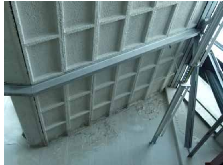
Sheddak met bimsbetonnen cassettepaneel
