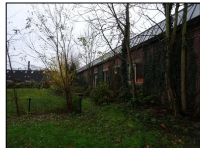
Figuur 5. Zicht op begroeiing en de zijgevel van gebouw 1.
