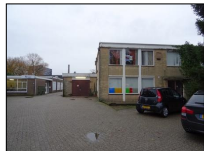
Figuur 8. Rechts gebouw 3 en links gebouw 4.
