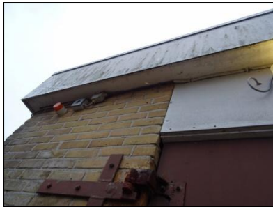
Figuur 10. Dichte betimmering in gebouw 3.
