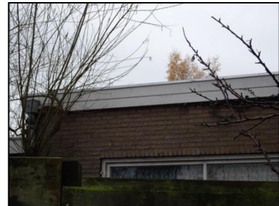
Figuur 12. Groei van klimop langs de dakrand op gebouw 5.
