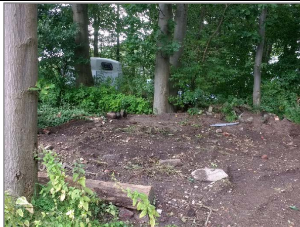
Foto 8: recentelijk graafwerkzaamheden uitgevoerd
