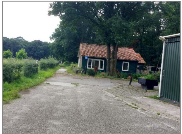
Foto 2: erf asfalt- en klinkerverharding
