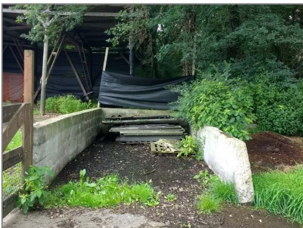
Foto 5: mest opslag (onder betonplaat circa 1,5 meter puin)
