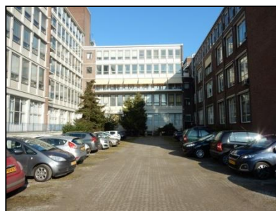
Figuur 4. Westgevel bouwdeel 7 en bouwdeel 8.
