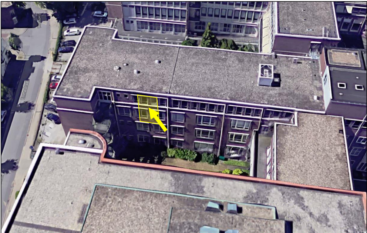
Figuur 21. De gele pijl geeft de exacte locatie van de invliegopening van de zomerverblijfplaats van een gewone dwergvleermuis weer. Het gele vlak geeft het gebied weer waar geen steigers geplaatst mogen worden.
