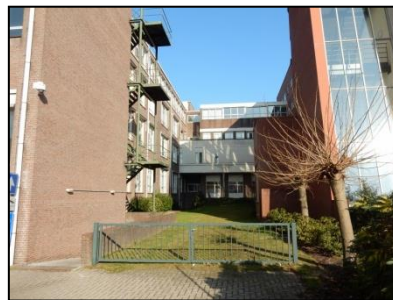
Figuur 4. Eén van de zuidelijke vleugels.
