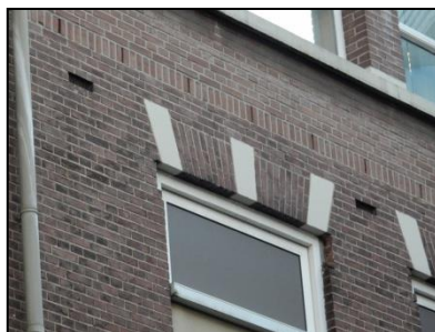
Figuur 11. Gevels met openingen naar de spouwmuur, geschikt voor gewone dwergvleermuizen en laatvliegers.
