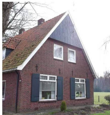
Foto 12: Het woonhuis, gezien vanaf de oprit. In eerste instantie lijken de luiken, het pannendak en de houten delen geschikt voor vleermuizen.
