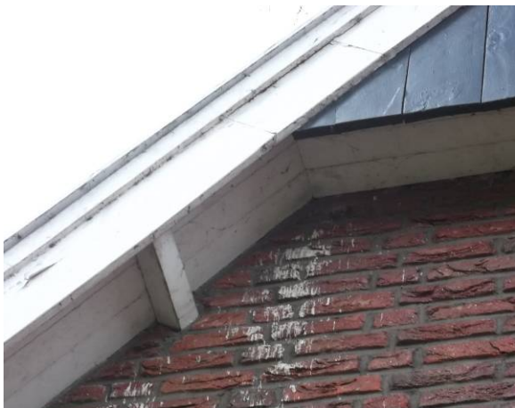
Foto 17: Bij nauwkeurigere inspectie blijken op deze gevel ook restanten (een donkere kring) van huiszwaluwnesten aanwezig te zijn.
