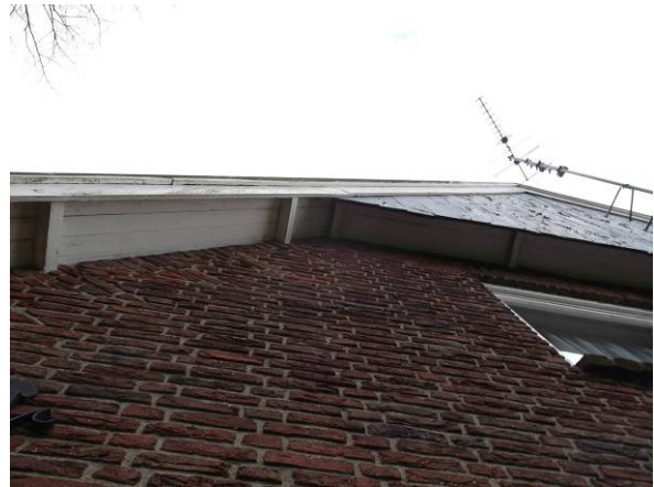
Foto 14: Tussen de houten delen en de muur zijn geen invlieg mogelijkheden voor vleermuizen. De dakpannen liggen vastgemetseld op het dak.
