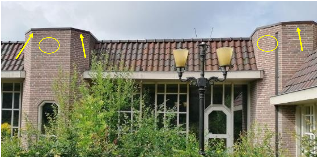
Zichtbare openstootvoegen vormen potentiële invliegopeningen in de aanbouw.
