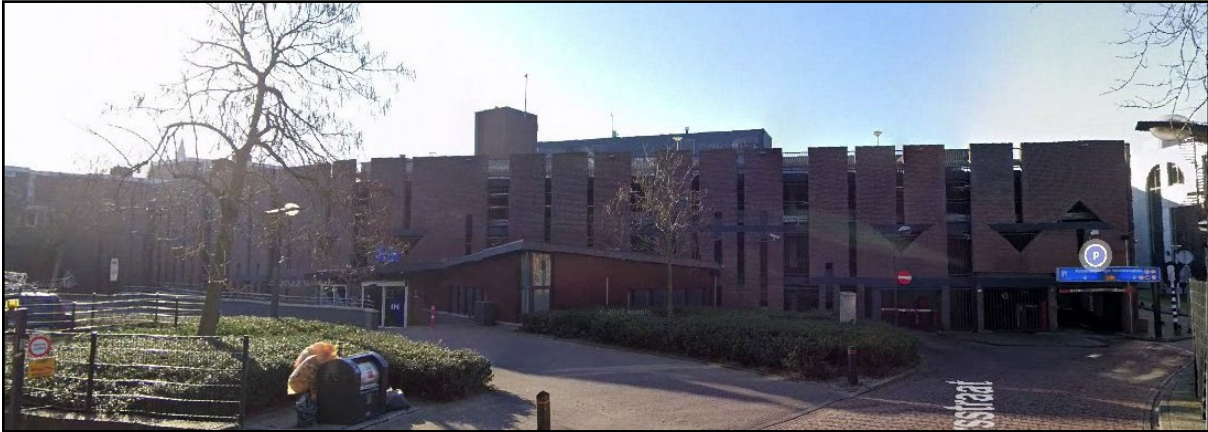
Afbeelding 2.3 Gevel 2022 achterzijde ABN
