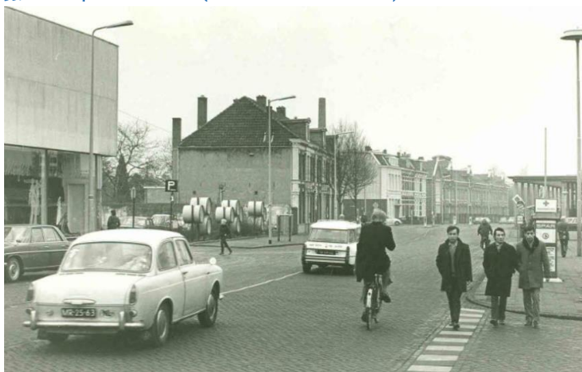
Het Stationsplein in 1972, met links nog een restant met etalages van de verder reeds grotendeels gesloopte fabriek. Op de achtergrond links van het midden de drie geschakelde woningen uit 1890. (bron: gemeente Enschede)
