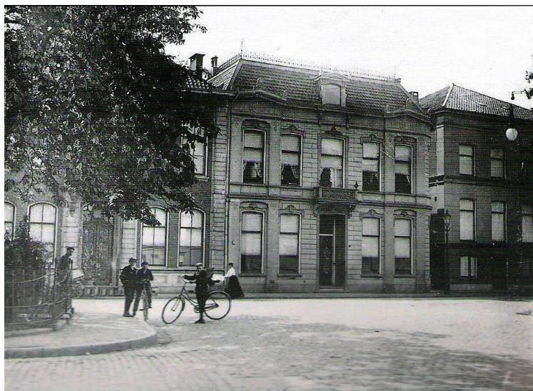
Haaksbergerstraat kruispunt de Graaff, links een stukje tuin van hotel de Graaff, achter de boom de nog bestaande villa waar later apotheker Baurichter zich zou vestigen, dan de villa van Helmich van Heek, afgebroken in 1907 om plaats te maken voor de ontsluiting van de stadsweide (Brammelerstraat), en rechts de villa van Piet ter Kuile in 1936 ter sloping verkocht aan V&D, deze foto is van rond 1900.
