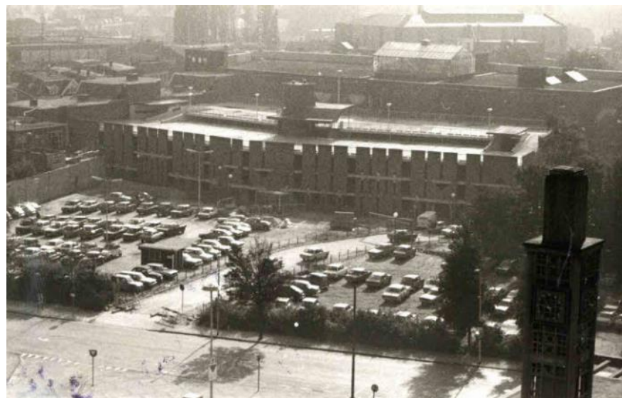
Foto van de bouw van de parkeergarage uit 1977. De bebouwing aan het Stationsplein is reeds geheel gesloopt. (bron: Stadsarchief Enschede, identificatienummer 000985).
