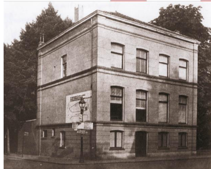
Woonhuis van familie Ter Kuile op de hoek van de Hengelosestraat en de Brammelerstraat in 1920. In 1937-38 werd dit pand vervangen door het warenhuis V&D (bron: Stadsarchief Enschede, identificatienummer 005242).
