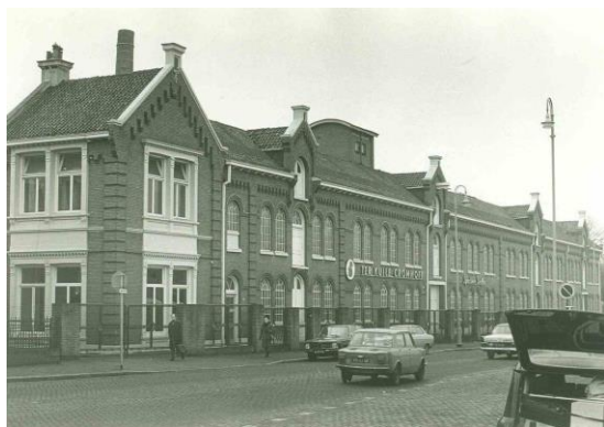
Foto van textielfabriek Ter Kuile Cromhoff meer westelijk gelegen langs de Parkweg, datering jaren 60-70 (bron: Gemeente Enschede).
