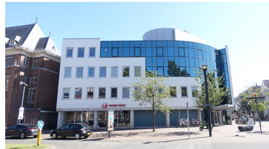
Hoedemakerplein 2-2a, westgevel
