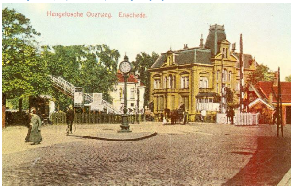
Spoorwegovergang en villa Kleiboer in 1905. Het Stationsplein is nog ingericht als Atjéhpark (bron: Stadsarchief Enschede, identificatienummer 002559).
