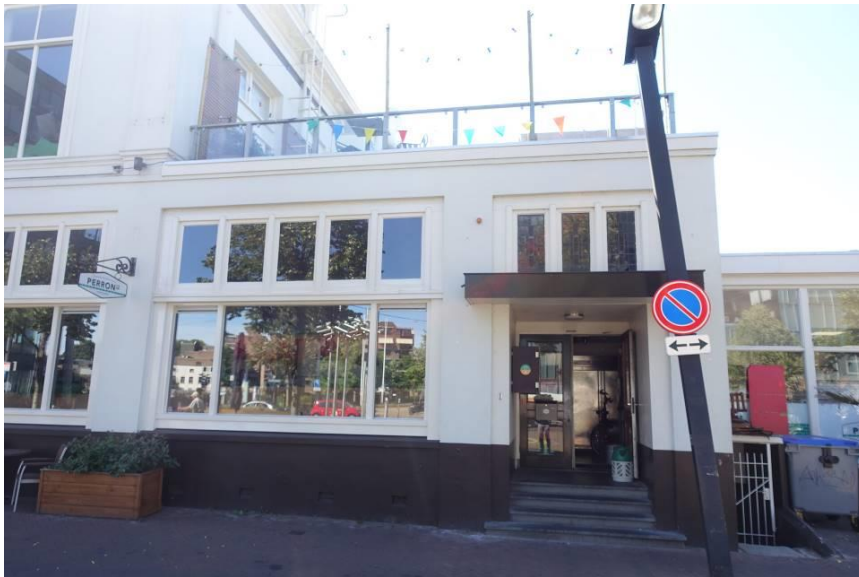
De éénlaags aanbouw met in de in 1961 verbouwde entree aan het Stationsplein dateert uit 1926. FH MAB 2020
