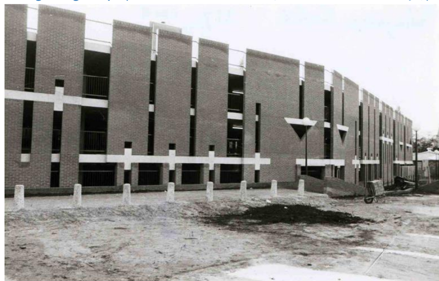
Foto van de bouw van de parkeergarage uit 1977 (bron: Stadsarchief Enschede, identificatienummer 000987).
