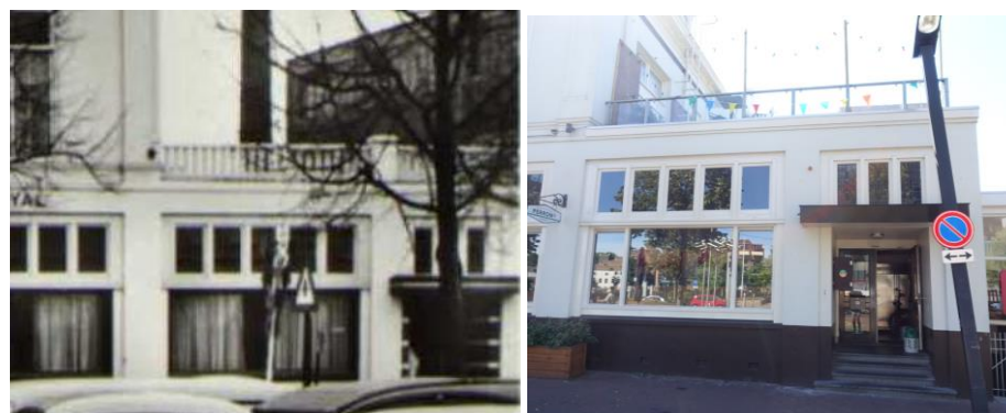
Aanbouw in 1961 met oorspronkelijke balustrade en aanbouw in 2020 (rechts).
