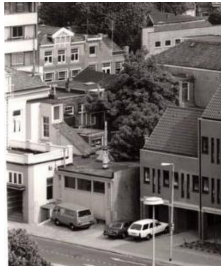
Links op de foto zijn de aanbouwen te zien van Stationsplein 1 in het begin van de jaren 80. De balustrade op de aanbouw aan het plein is dan nog in de oude vorm aanwezig. Daarachter is het trappenhuis vanuit de aanbouw naar de verdieping te zien.
