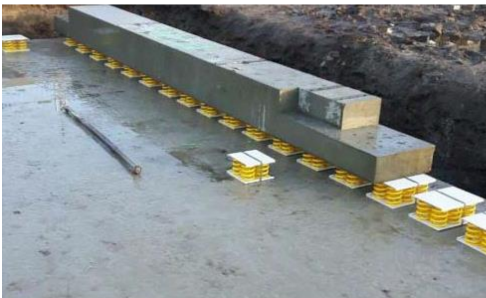
Figuur 23 Dubbele fundering met stalen veerdozen (project in Prinsenbeek)
