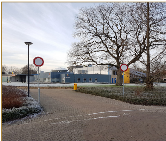
Afb. 2.1: Hoofdgebouw zwembad gezien vanaf de parkeerplaats ten oosten van het terrein.
