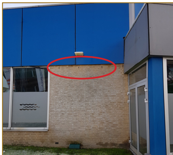
Afb. 2.5: Geschikte openingen in de spouwmuur van de noordwestgevel.
