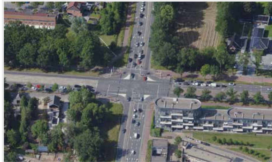
Beperkte geluidshinder van de Gronausestraat
