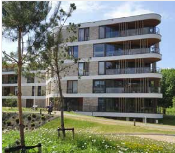
Entreegebouw aan de Gronausestraat accent in hoogte
