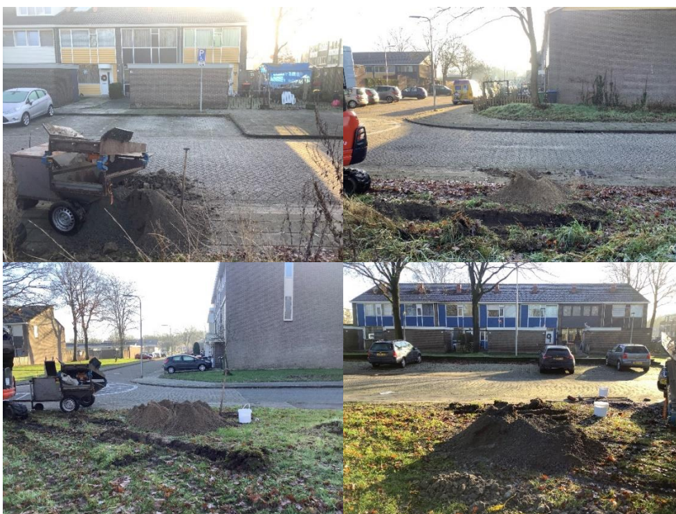
Afbeelding 3.2: Locatie overige sleuven nader asbestonderzoek.
